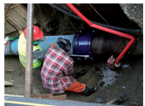
Einfachste Montage mit je einer leicht zugänglichen Schraube (ab DN 350 zwei Schrauben pro Seite)
